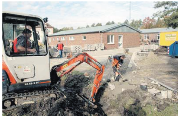
Das Seniorenheim des CVJM-Sozialwerks an der Einwarder Werftstraße wird zurzeit auf 21 Plätze ausgebaut.
